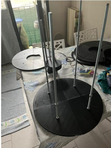
In seguito, ho inserito lungo le viti filettate il pavimento e i dadi m8 per fissare il piano
